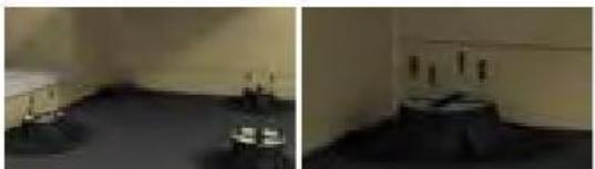
3.U terčů s pevnou výškou v blízkosti atiky a stěn rozříznout terč na dvě půlky a použít právě jednu z nich. V místě vnitřního rohu rozříznout terč na čtvrtiny a použít právě jednu z nich. V místě vnějšího rohu použít  $\frac{1}{4}$ .
